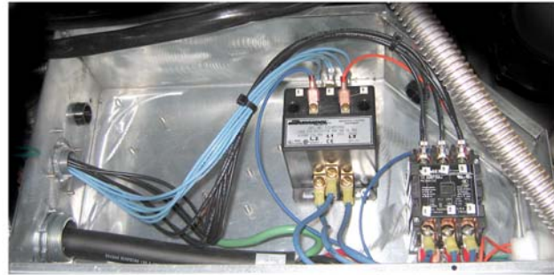
Venstre og høyre sider av mekaniske kontaktorbokskomponenter.
