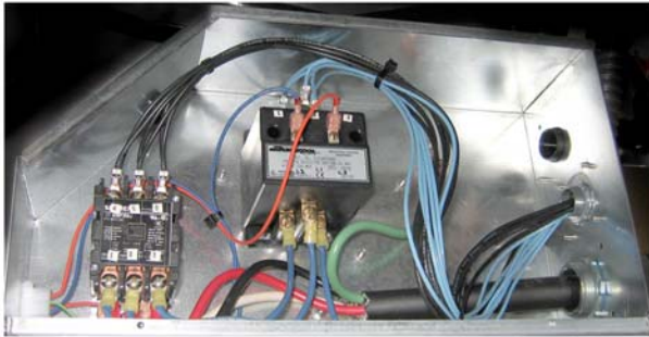
Venstre og høyre sider av mekaniske kontaktorbokskomponenter.
